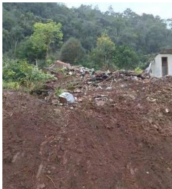
Foto 95 - Desmoronamento em propriedade rural no interior de Sinimbu
